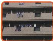
集合住宅の廊下・ロビー
